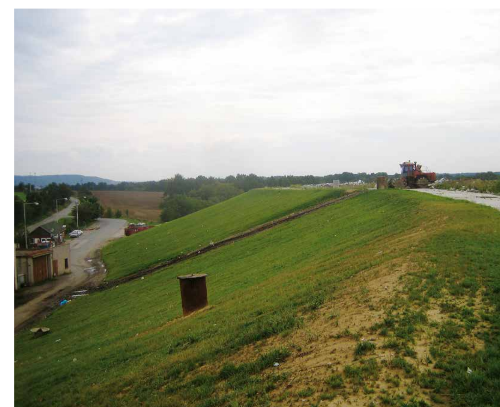
Povrchové těsnění sklárky tuhého komunálního odpadu Surface sealing of a municipal landfill
