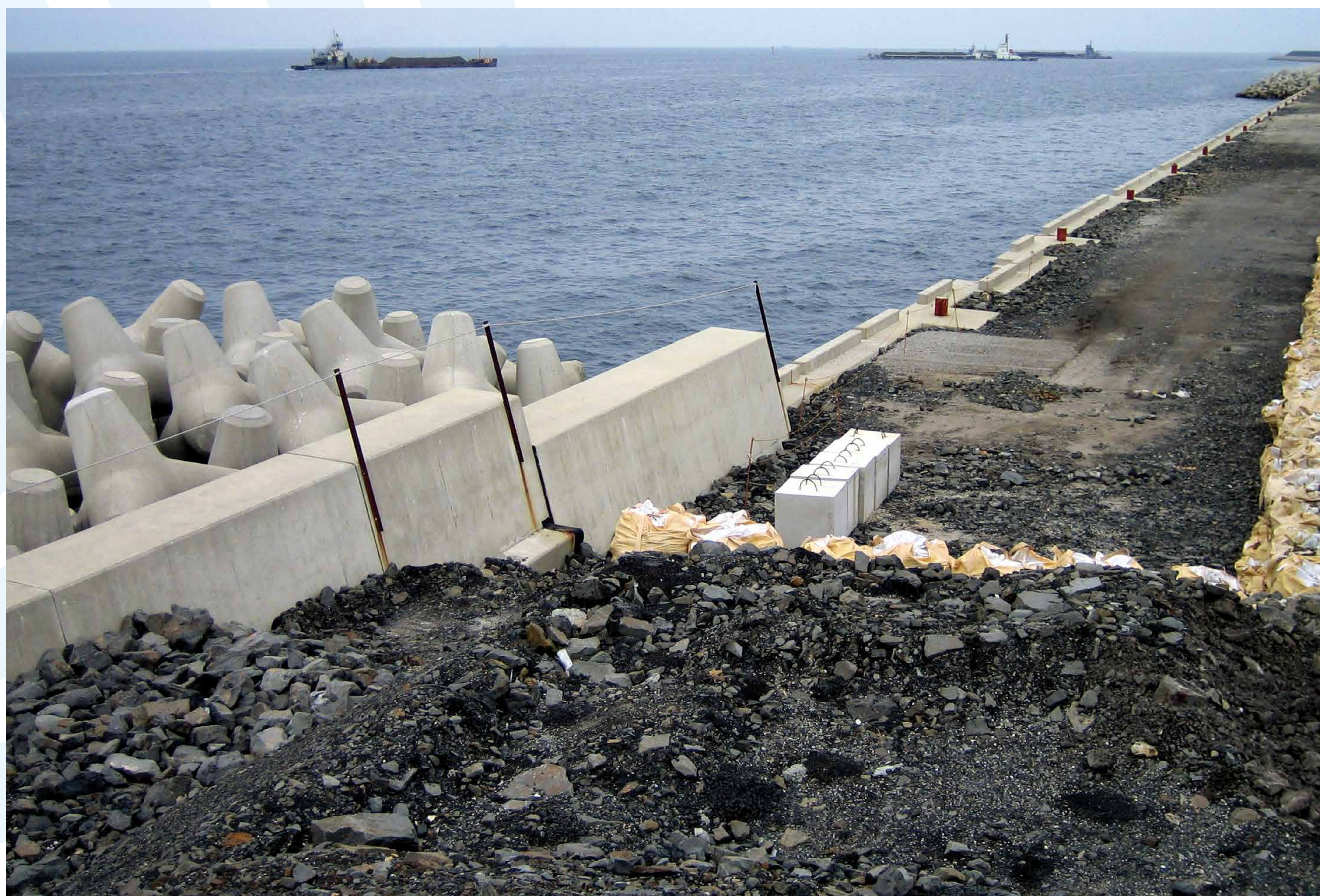
Rozšiřování letiště na mořském dně – Ósaka, Japonsko Widening of an airport constructed on a seabed – Osaka, Japan
