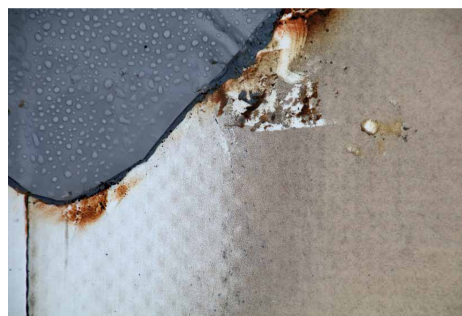
Pokus o marné svařování vystaralé nové fólie Unsuccessful attempt to weld an old and a new foil
