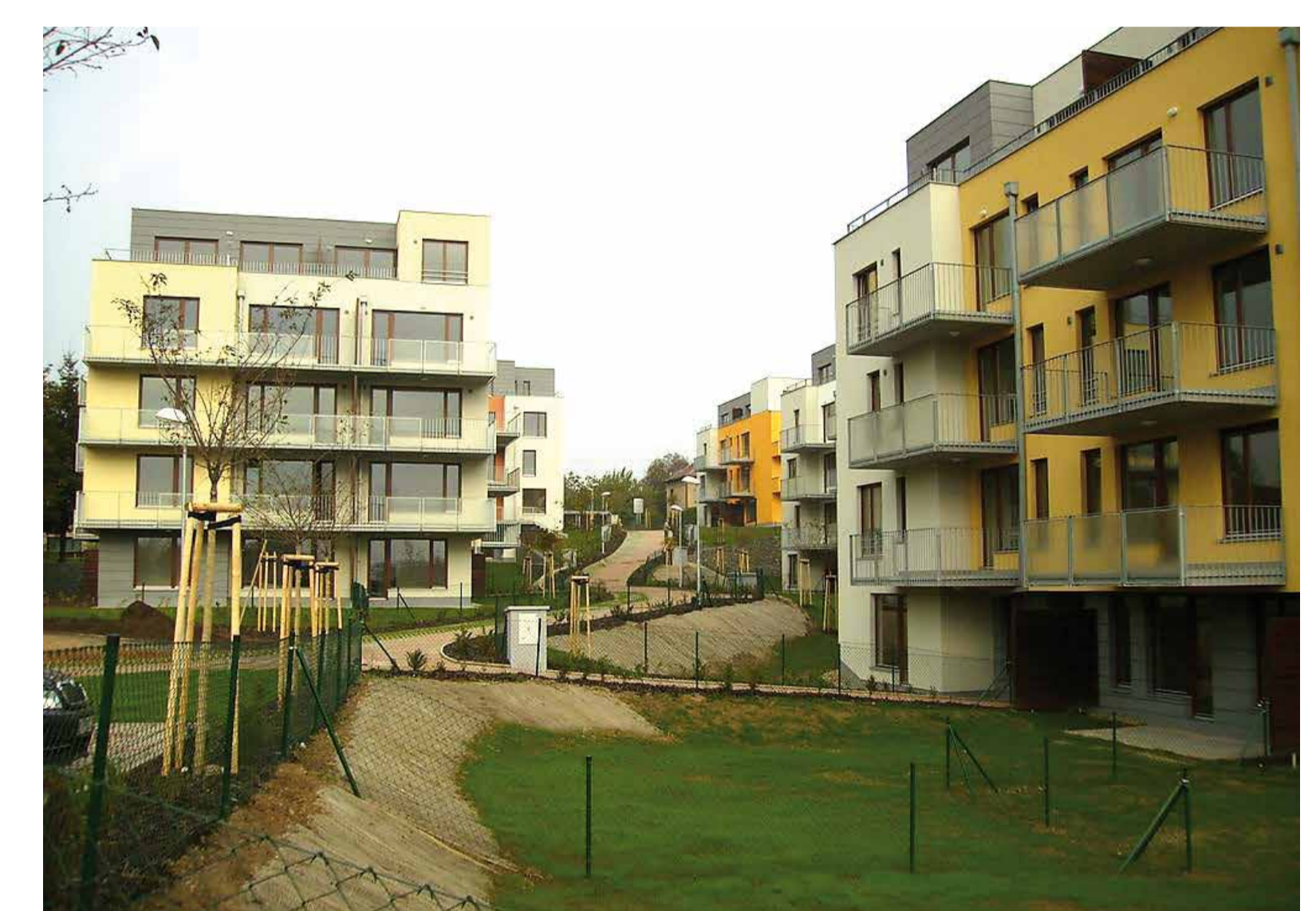
Přístupnost pro opravy – na střeše společného suterénu jsou soukromé zahrádky; hydroizolace garáží a teras je obtížně přístupná pro opravy, protože je zakryta dalšími vrstvami a plocha na nich patří vlastníkovi, který nemá vztah k defektům hydroizolace Access for repairing – there are private gardens of the common basement's roof; waterproofing on the garage and terraces is hardly accessible for repairs because it is covered with other layers and their areas belong to another owner, who is in no relation to defects of waterproofing
