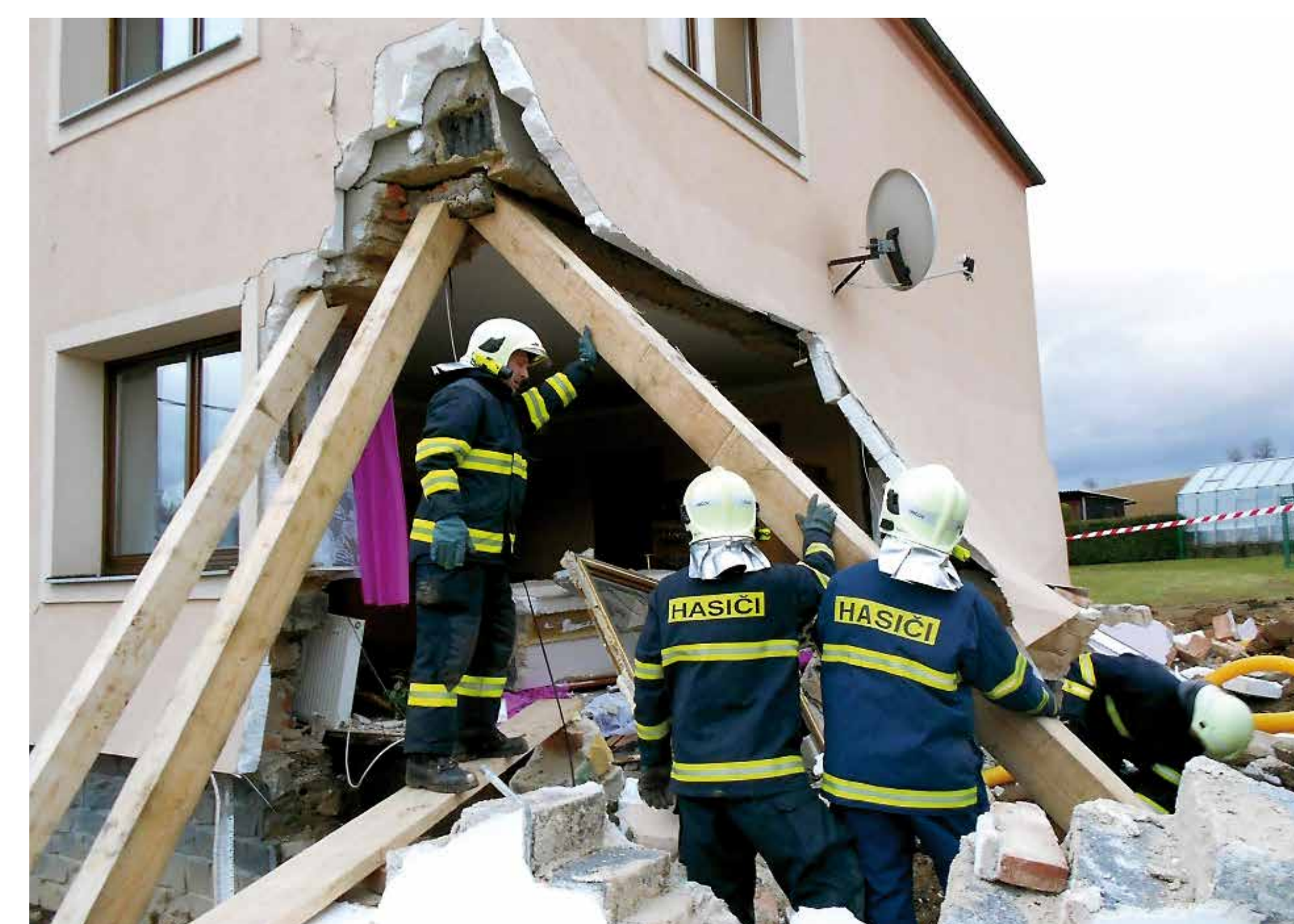
Chyba při realizaci dodatečné drenáže. Otevřený úsek výkopu byl příliš dlouhý a výkop ještě před odvodněním dna zaplavila voda z příválového deště, která způsobila rozřednutí zeminy. A mistake during the installation of supplementary drainage. The open section of the trench was too long, and torrential rain flooded the trench before drainage could be placed onto the bottom, making the soil slushy.
