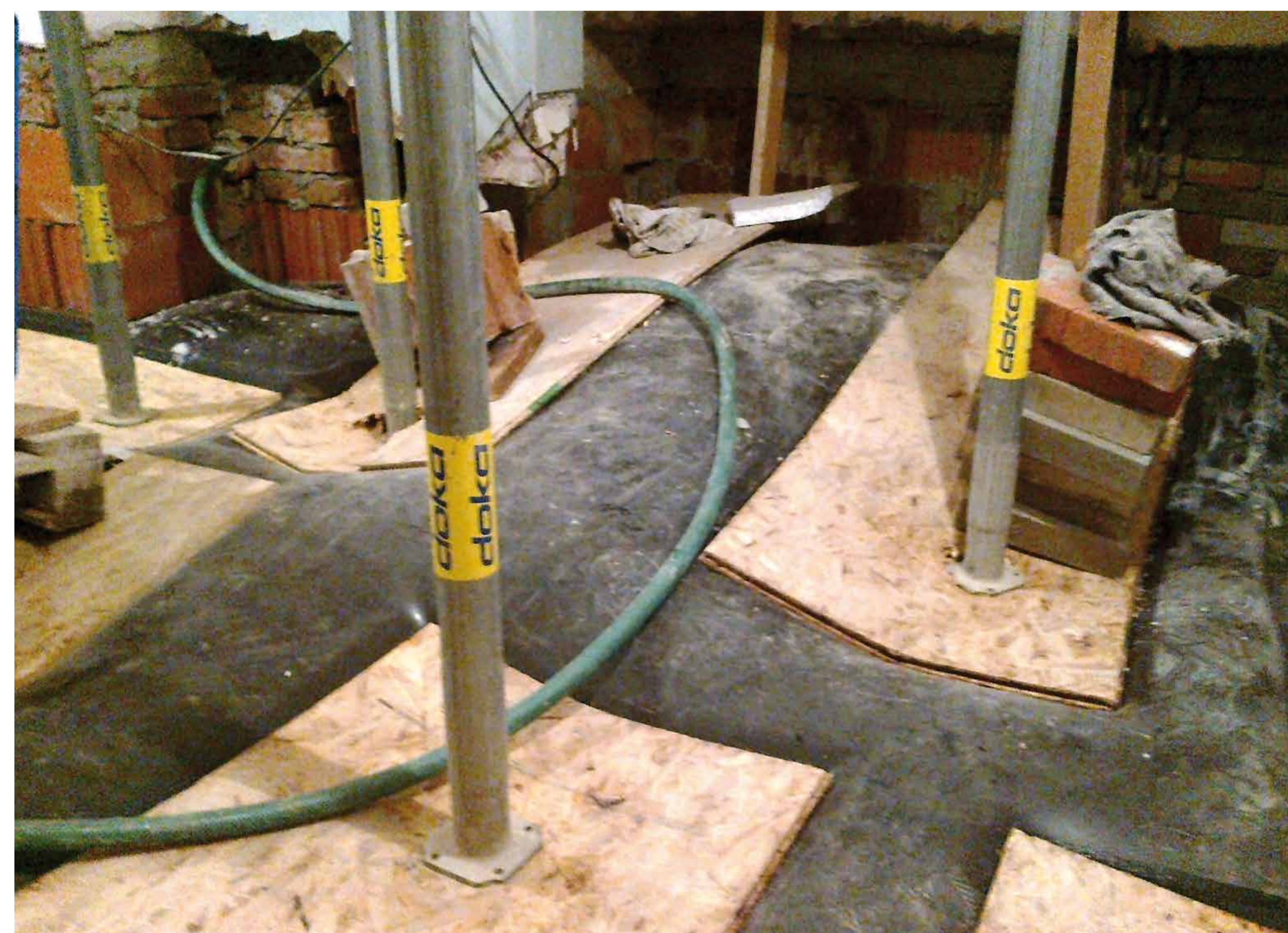
Návrh hydroizolace nepředpokládal riziko zaplavení záspů kolem suterénu vodou při příválových deštích. Při opravě této nedostatečně hydroizolace znovu přišly vydatné deště. The waterproofing project had not anticipated the risk of flooding of backfills around the basement during torrential rains. Heavy rain continued during the repairs of this inadequate waterproofing.
