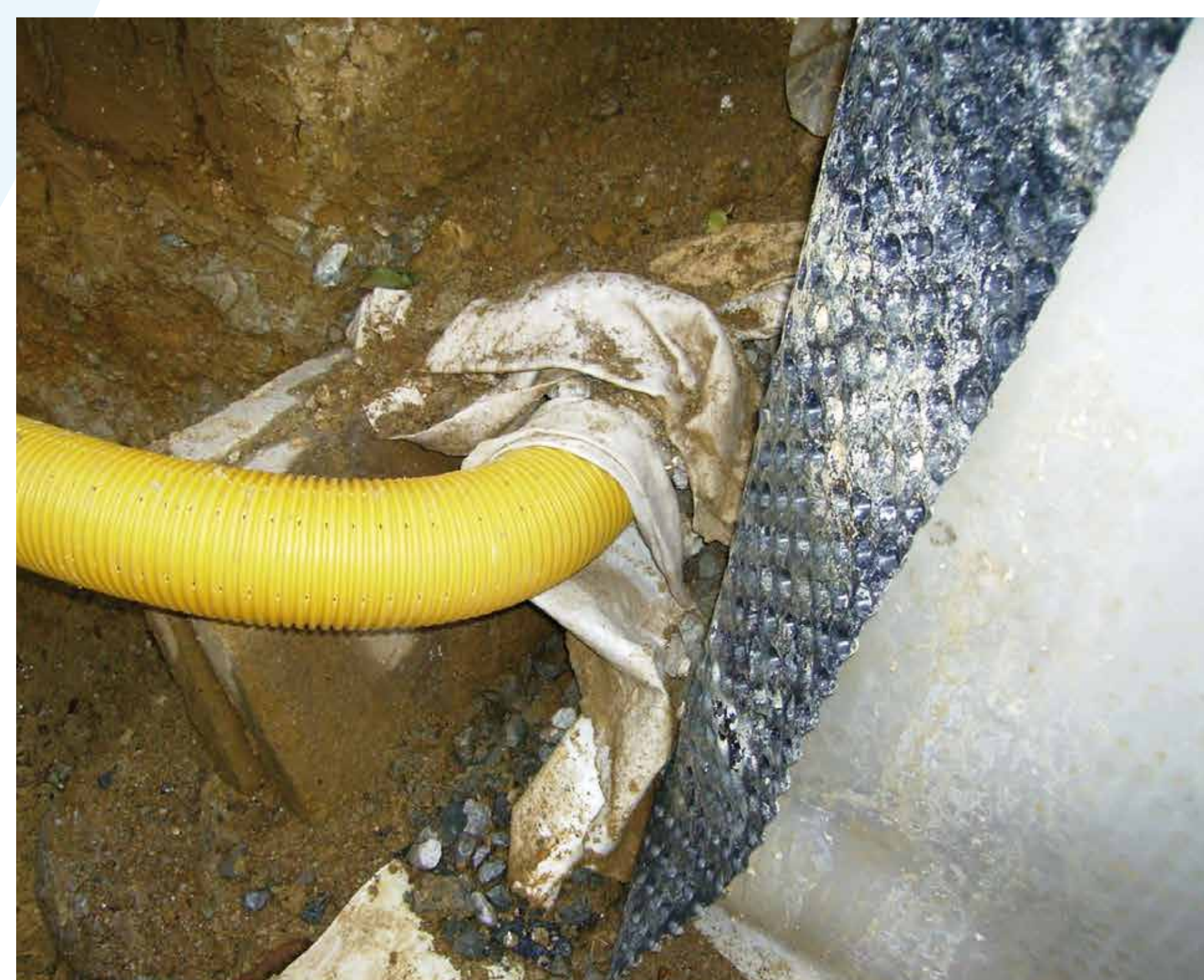
Vlevo je nevhodné umístění obvodového drenážního potrubí nad úrovní vodorovné hydroizolace. Vpravo jsou důsledky v podobě silně vlhkého zdiva suterénu Left – inappropriate position of a perimeter drainage pipe above horizontal systematic drainage. Right – resultant very damp basement masonry.
