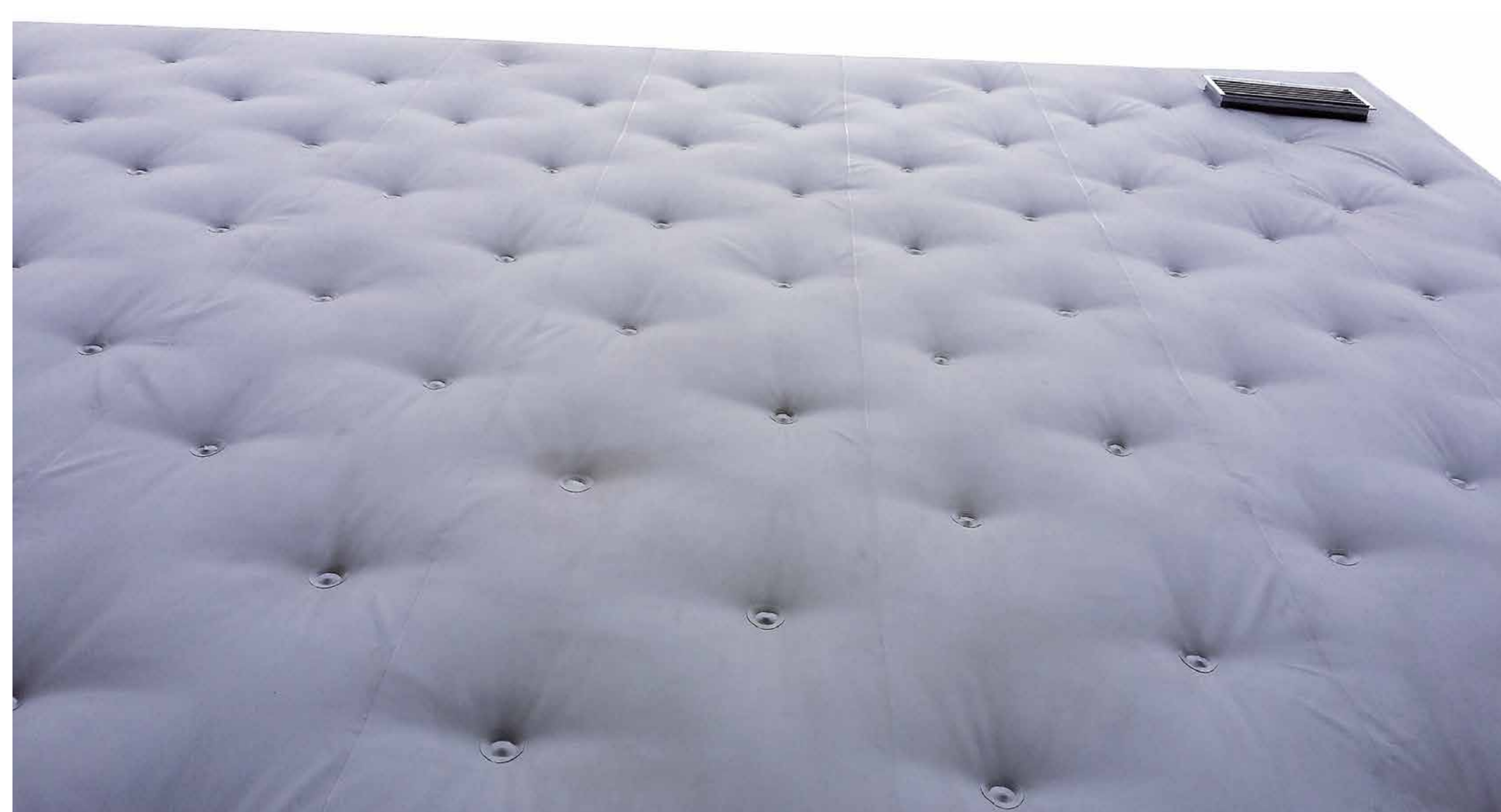
Detail finálního provedení čalouněné fasády – Centrum moderního umění NEW DOX, Praha Detail of the final upholstered façade – the extension of the Center for Modern Art, Prague, the Czech Republic
