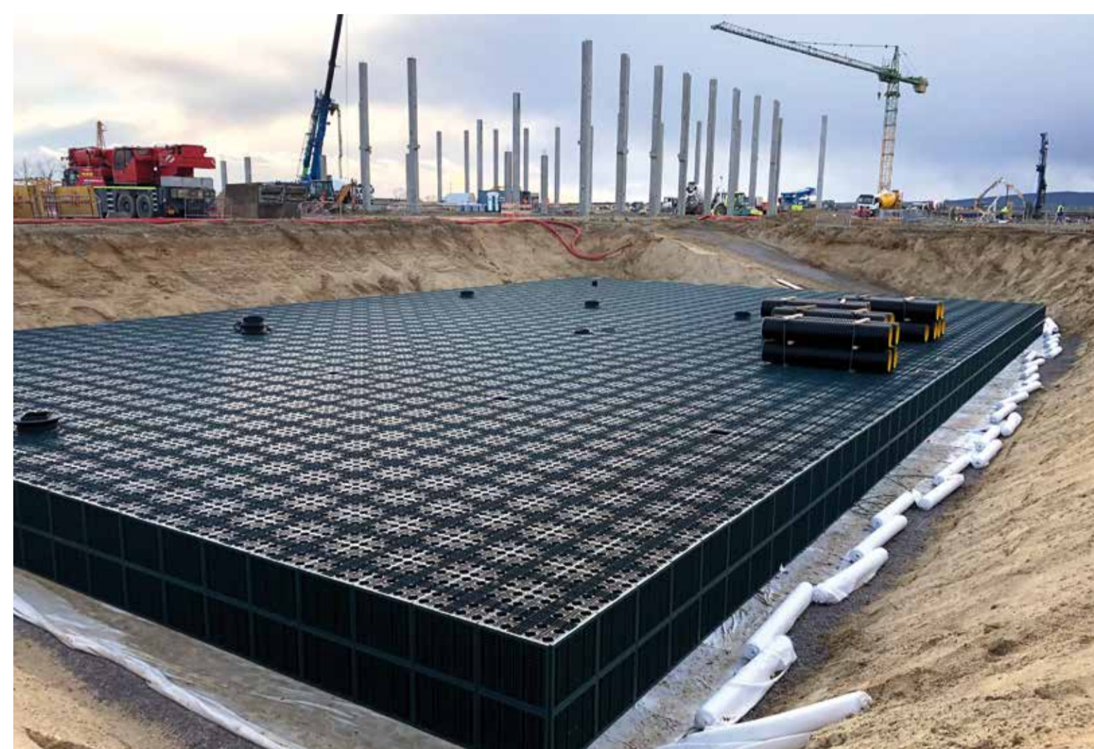
Realizace vsakovacího objektu Construction of the absorption structure
