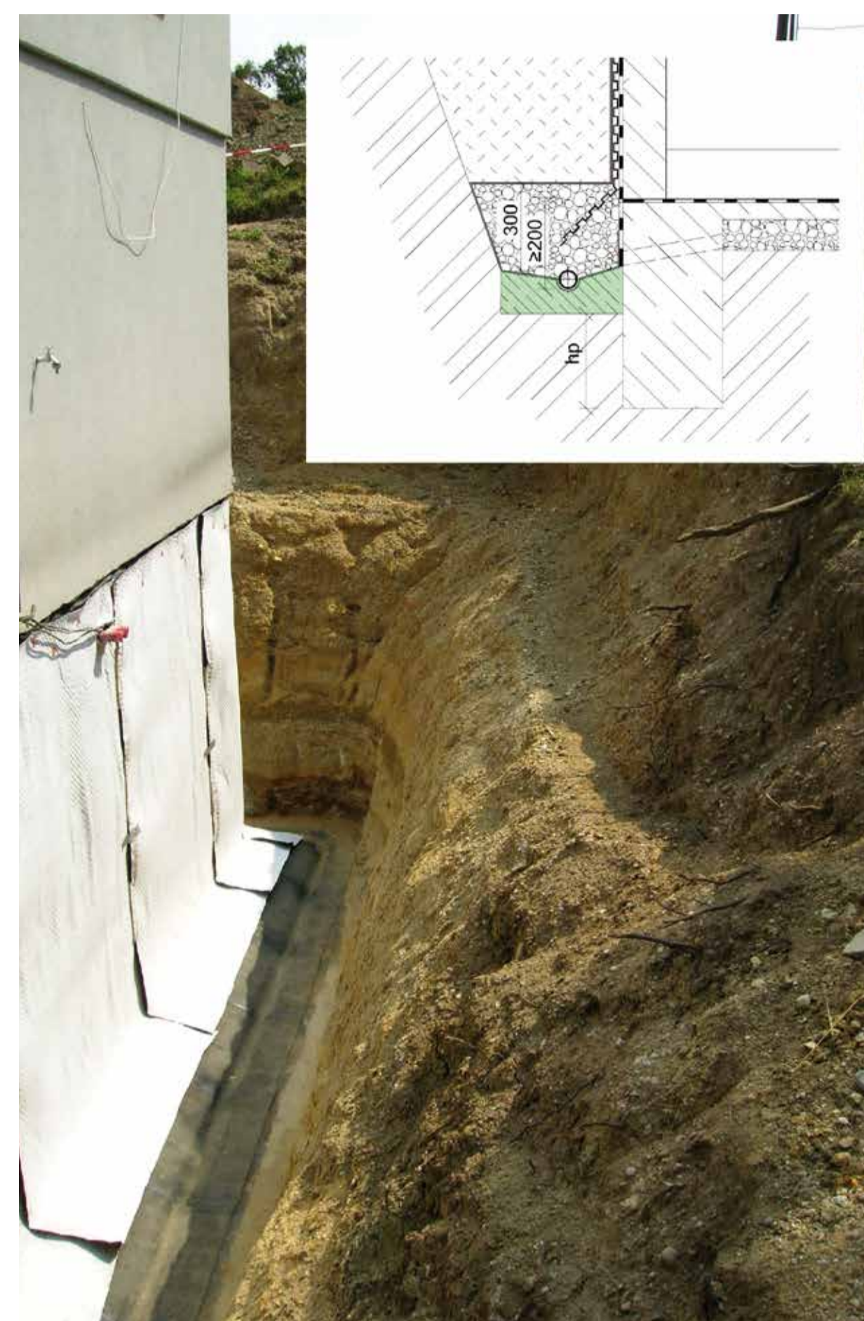
Uložení drenážního potrubí na betonové dno, realizace podzemní svislé plošné drenáže z profilované fólie a integrované geotextilie Placement of drainage pipe onto a concrete support; underground sheet drainage of profiled membrane and integrated geotextile
