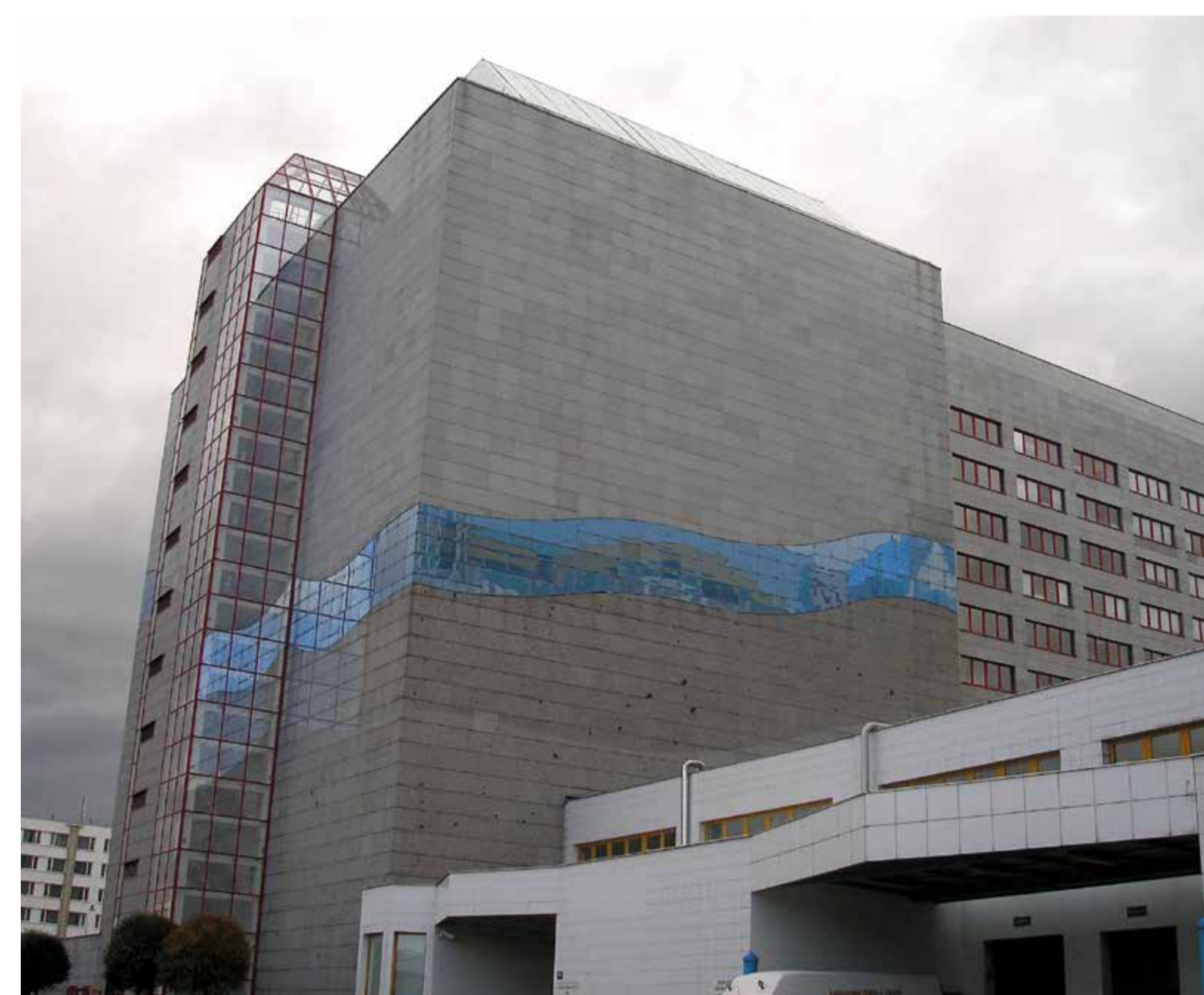
Objekt se skládaným pláštěm z kamenných desek – Archiv hl. m. Prahy Building with stone panel rainscreen – The Prague City Archives, the Czech Republic
