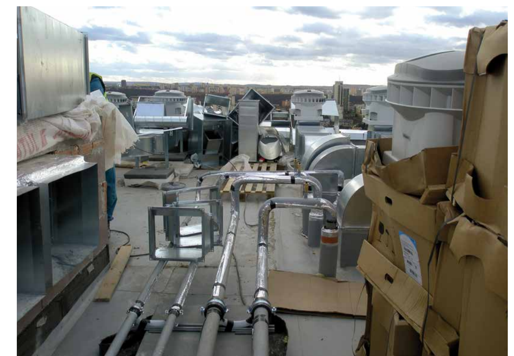
Vyhodnocení požadavků – postup výstavby má také vliv, střecha se stala zařízením staveniště, hydroizolace musí být zvláště odolná Assessment of requirements – the sequence of construction also plays its role; the roof was used as a site storage, waterproofing must be really heavy-duty.
