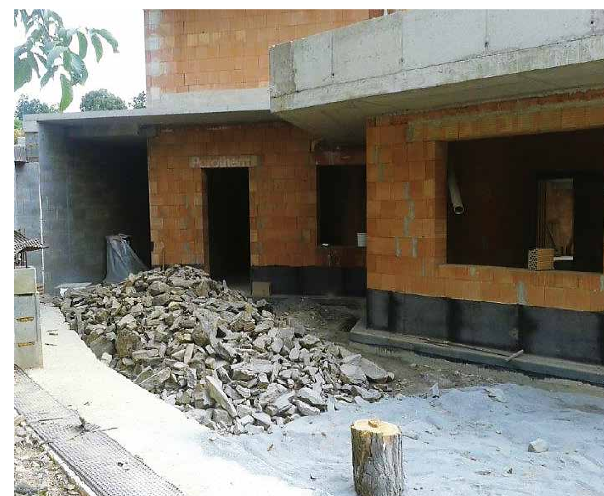
Realizace ochranného prostoru Construction of protection space
