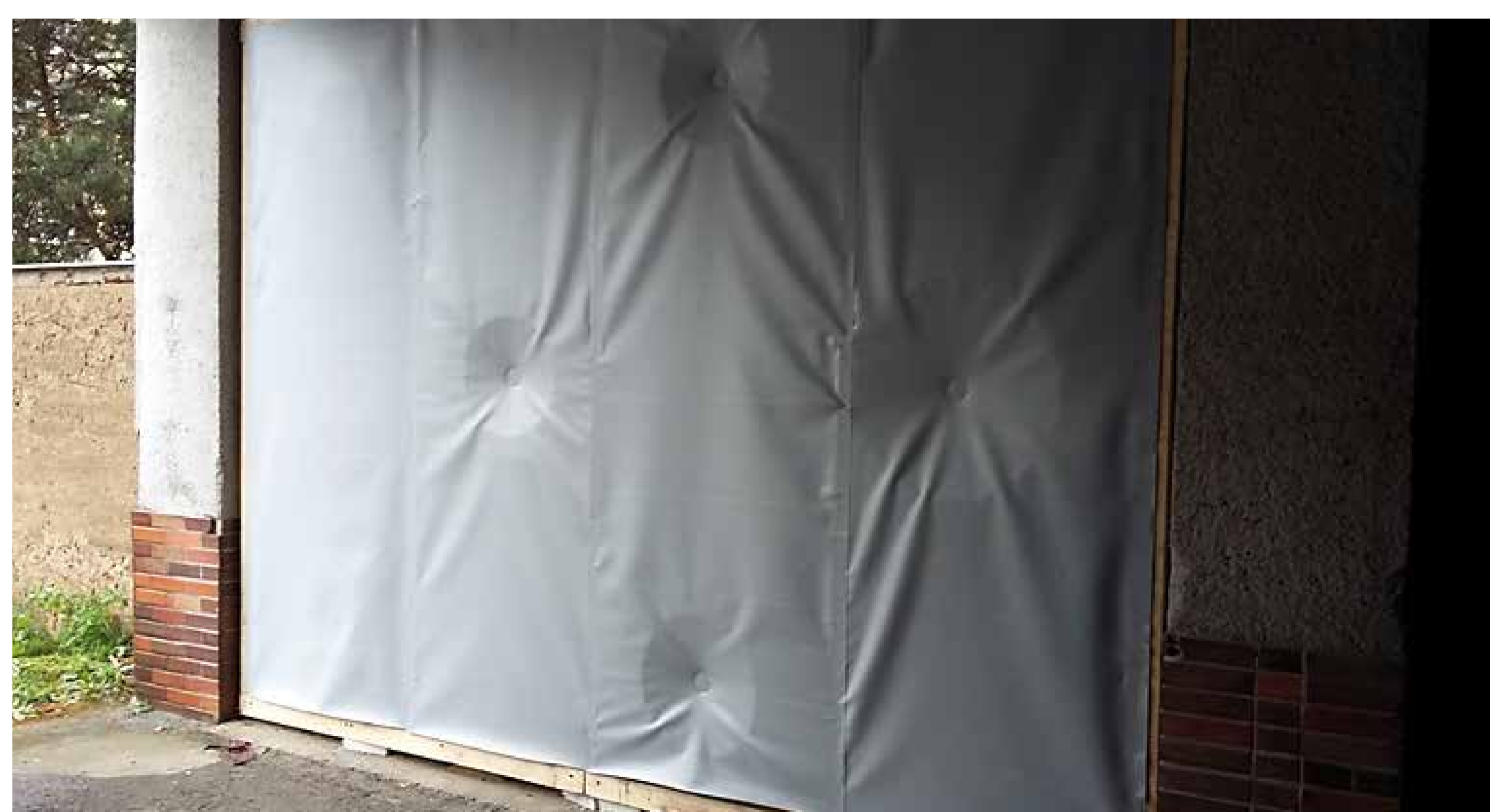
První pokusný vzorek provedení čalouněné fasády – Centrum moderního umění NEW DOX, Praha The first sample of the upholstered façade – the extension of the Center for Modern Art, Prague, the Czech Republic
