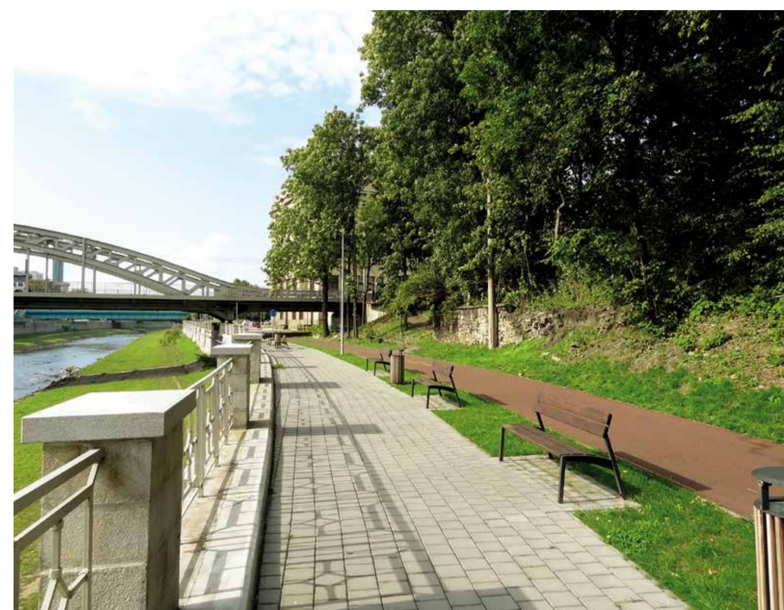
Srovnávací foto stávajícího stavu revitalizovaného prostoru před rekonstrukcí Comparative photo of the revitalized space before the revitalization
