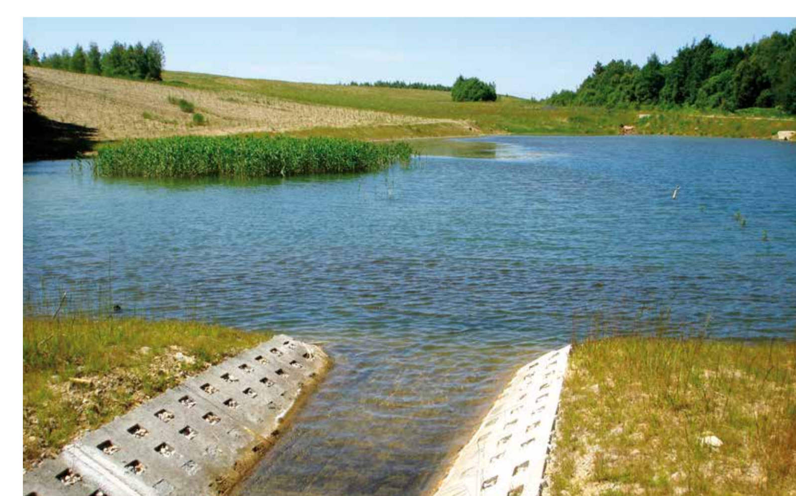
Tůň při patě Podkrušnohorské výsypky s horním přelivem Pool at the foot of the Podkrušnohorská výsypka (mine dump) with an upper spillway
