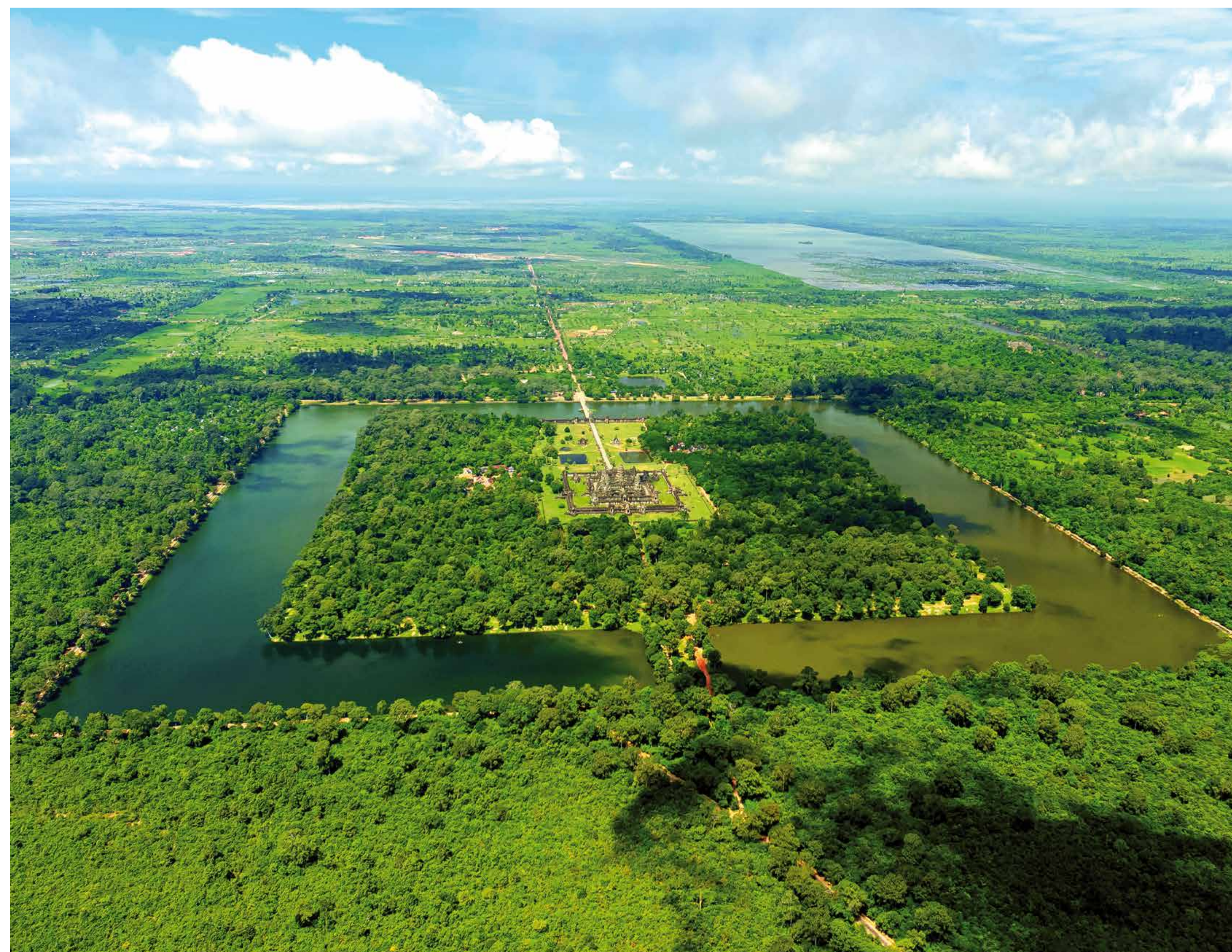
Areál chrámu Angkor Wat obklopený vodním příkopem, v pozadí nádrž Baray Teuk Thla (West Mebon) Angkor Wat surrounded by a moat; the Baray Teuk Thla (West Mebon) reservoir in the background.
