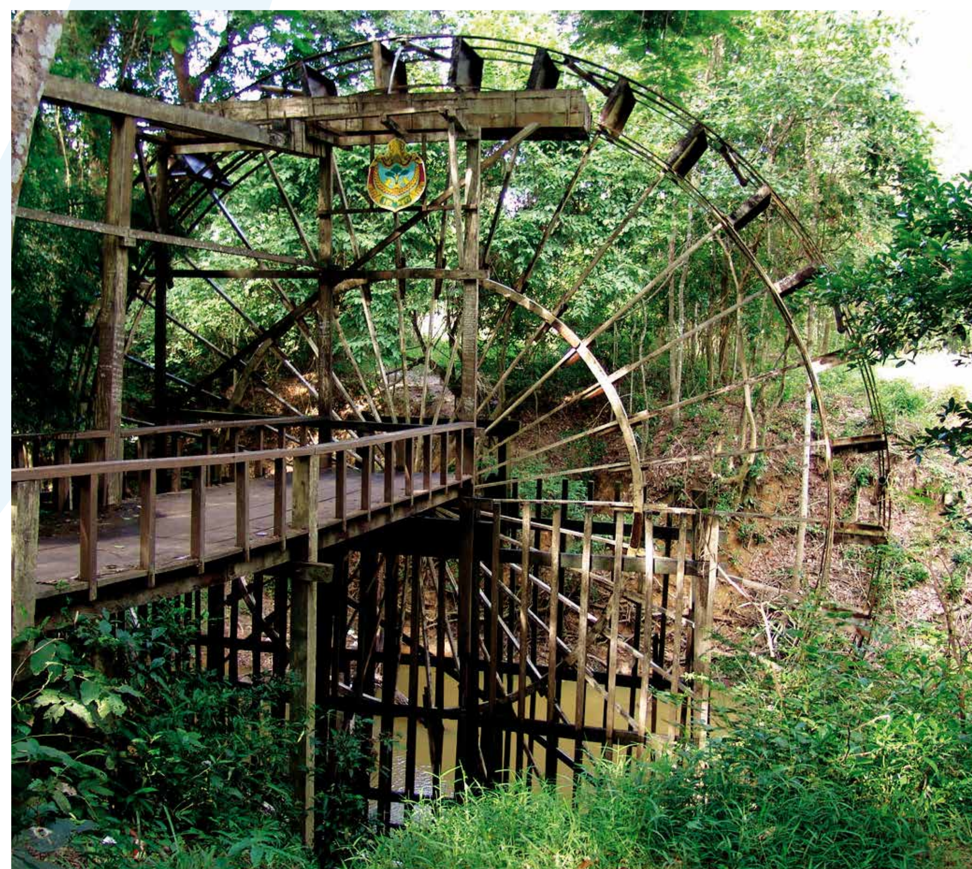
Vodní kolo hnané proudem řeky Siem Reap, které vynáší vodu do zavlažovacího systému A water wheel driven by the stream of the river Siem Reap supplying water to the irrigation system.
