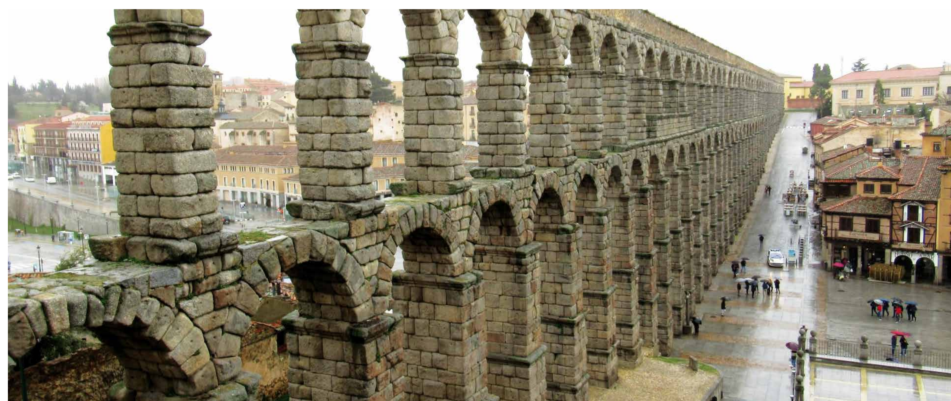
Akvadukt v Segovii, Španělsko Aqueduct in Segovia, Spain
