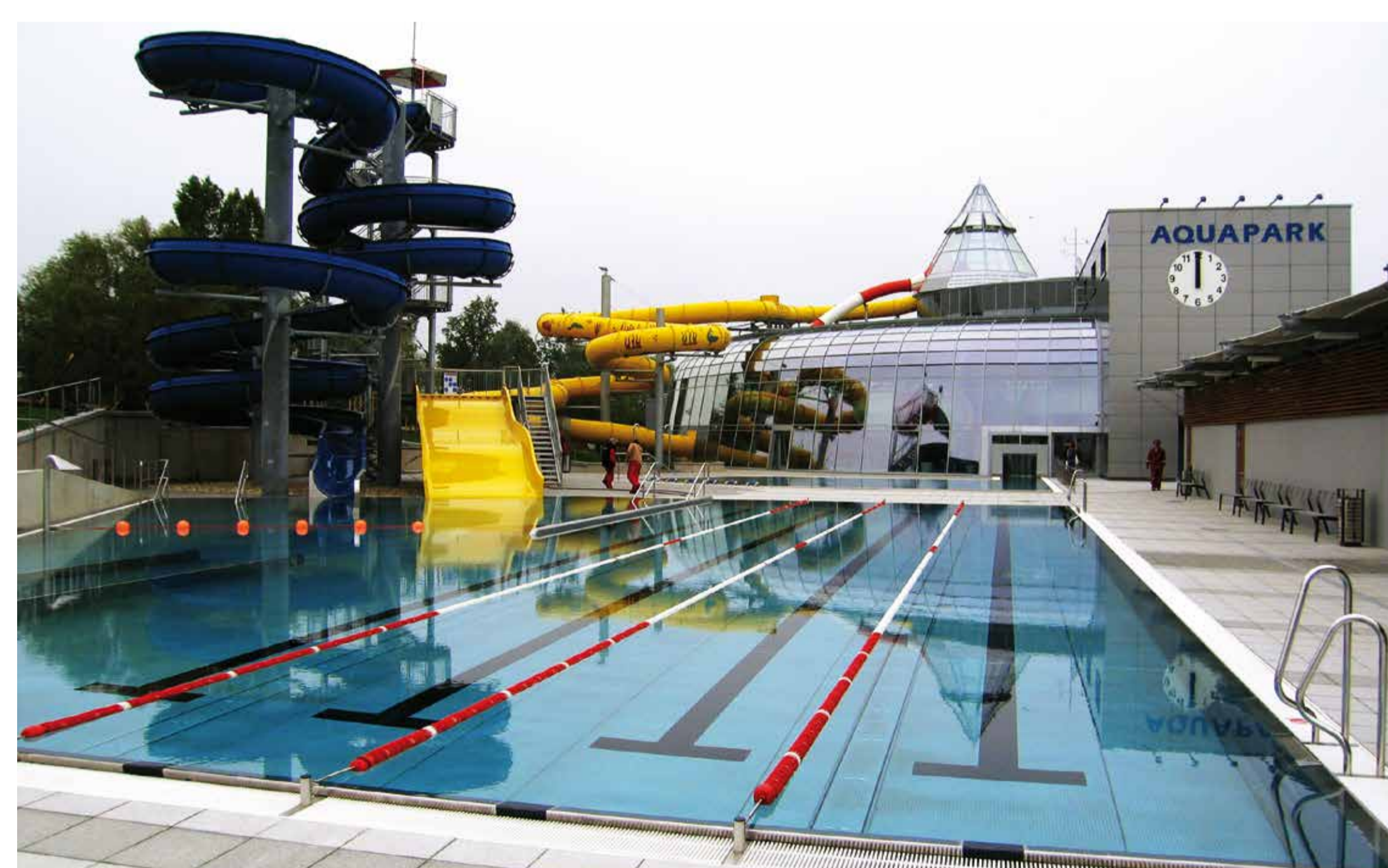
Perspektiva (západ) a exteriér (západ) Aquaparku Olomouc Aquapark Olomouc – perspective (west) and exterior (west)
