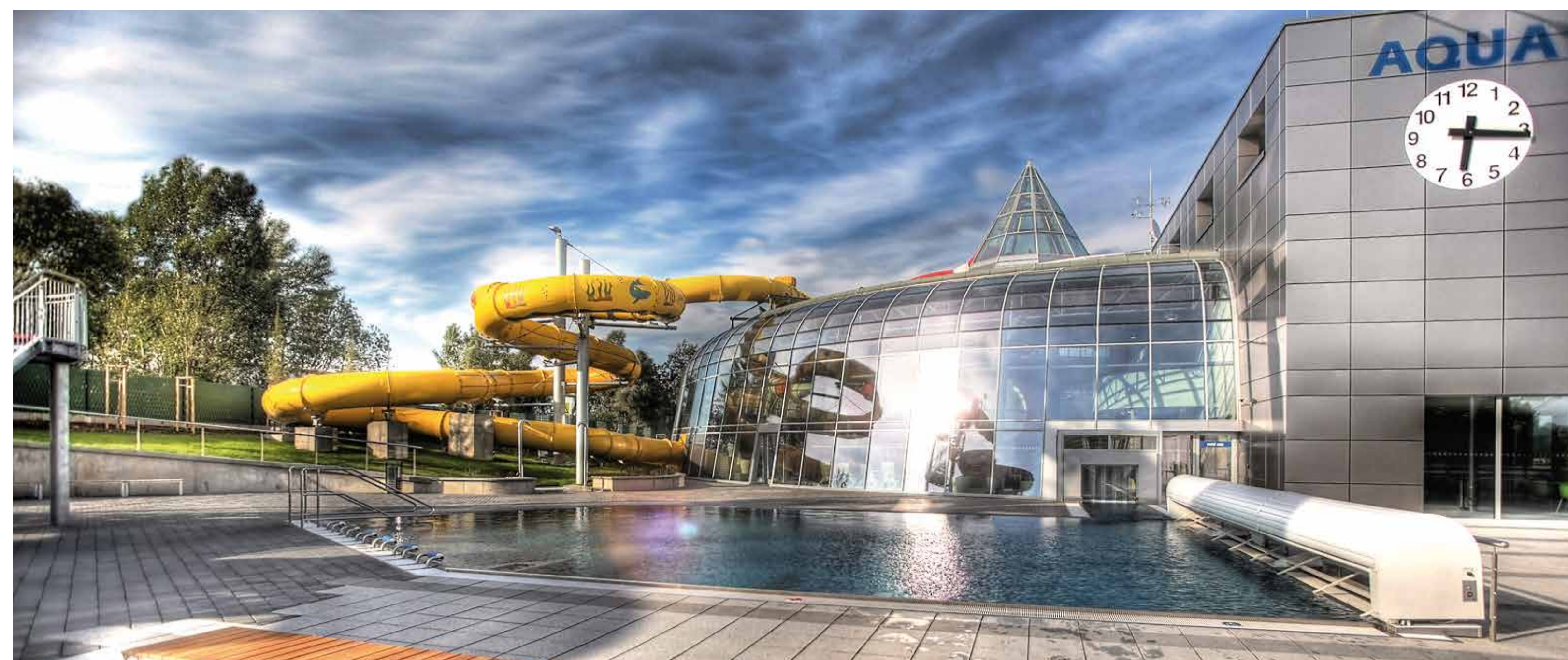
Venkovní vyhřívávaný bazén s proplouváním do vnitřní haly aquaparku Outdoor heated swimming pool with a canal for swimmers into the internal swimming hall
