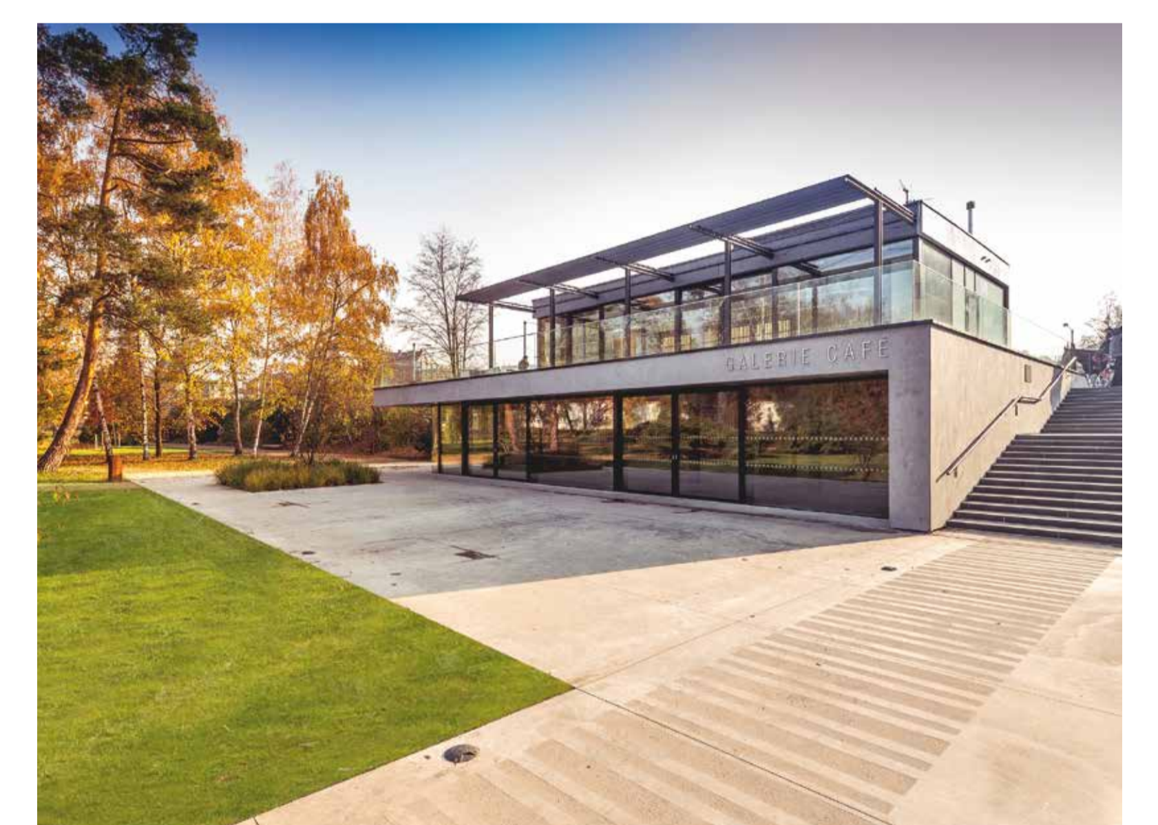
Galerie Café – horní podlaží v úrovni města, spodní podlaží patří vnořenému parku Gallery Café – the top storey on the town's streetscape level, the bottom storey belongs to the sunken park
