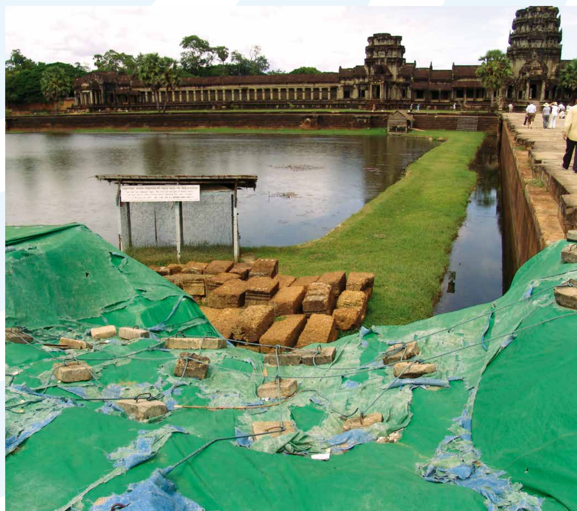
Pískovcová hráz s přístupovou cestou přes vodní příkop do areálu chrámu Angkor Wat A sandstone dam with an access road over the moat leading to the Angkor Wat complex.
