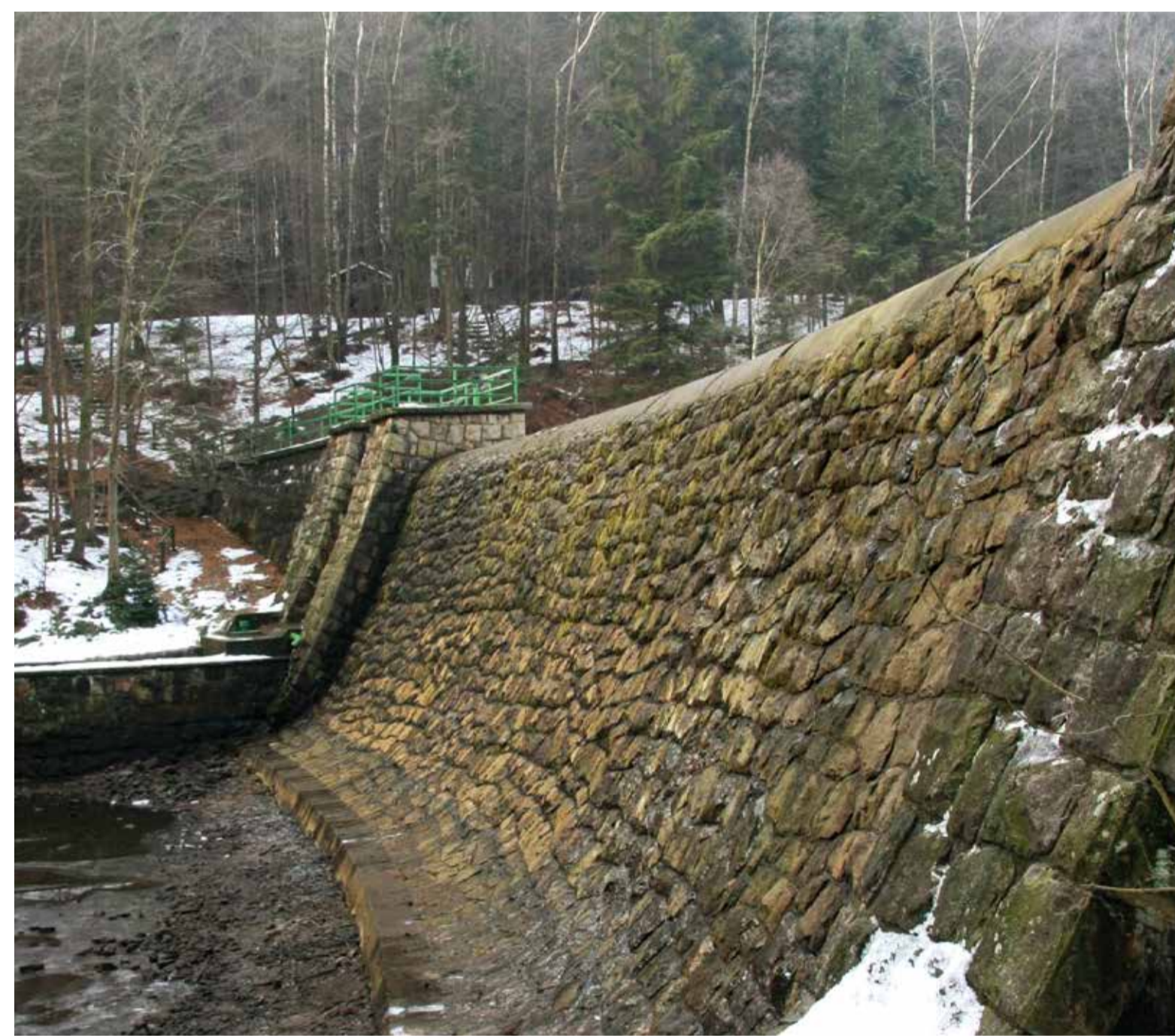
Vzdružení hráze VD Naděje, pohled na pravé zavázání tělesa Downstream shell of the Naděje Waterwork; view to the right-hand feather.
