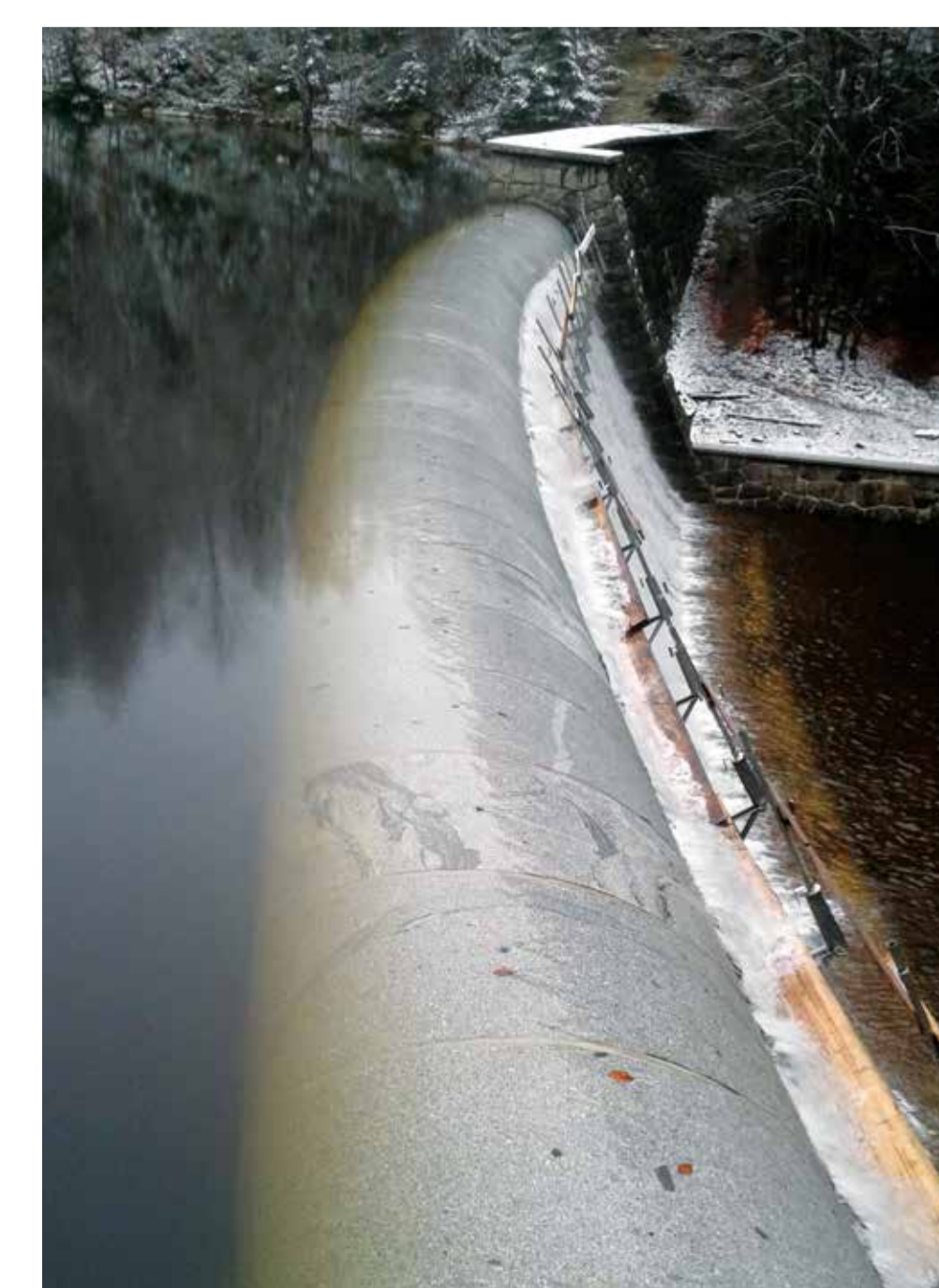
Pohled na přeliv po dokončení rekonstrukce; voda stabilně přetéká přes přelivnou hranu View to the spillway after the renovation; water flows continuously over the crest of the weir.
