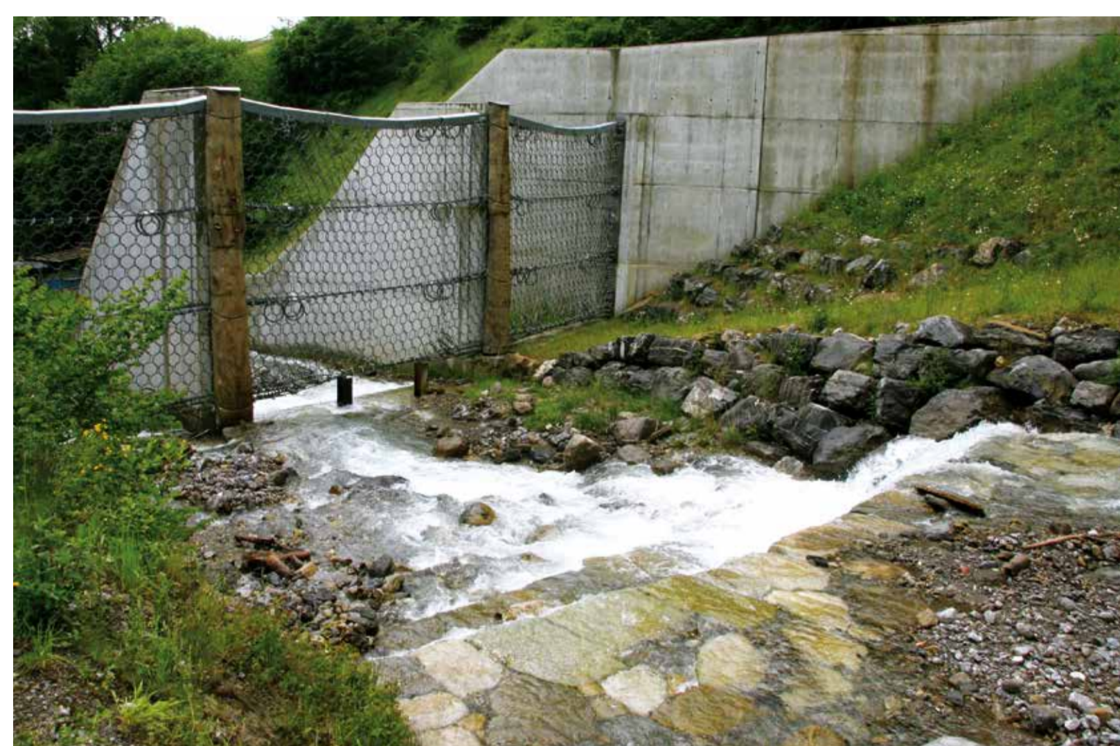
UX bariéra se dvěma opěrami, konstrukční výška kruhových sítí 6 m (Švýcarsko), lana jsou ochráněna kmeny stromů UX barrier with two retaining walls; the structural height of circular nets is 6 meters (the Swiss system); cables are protected by trunks.
