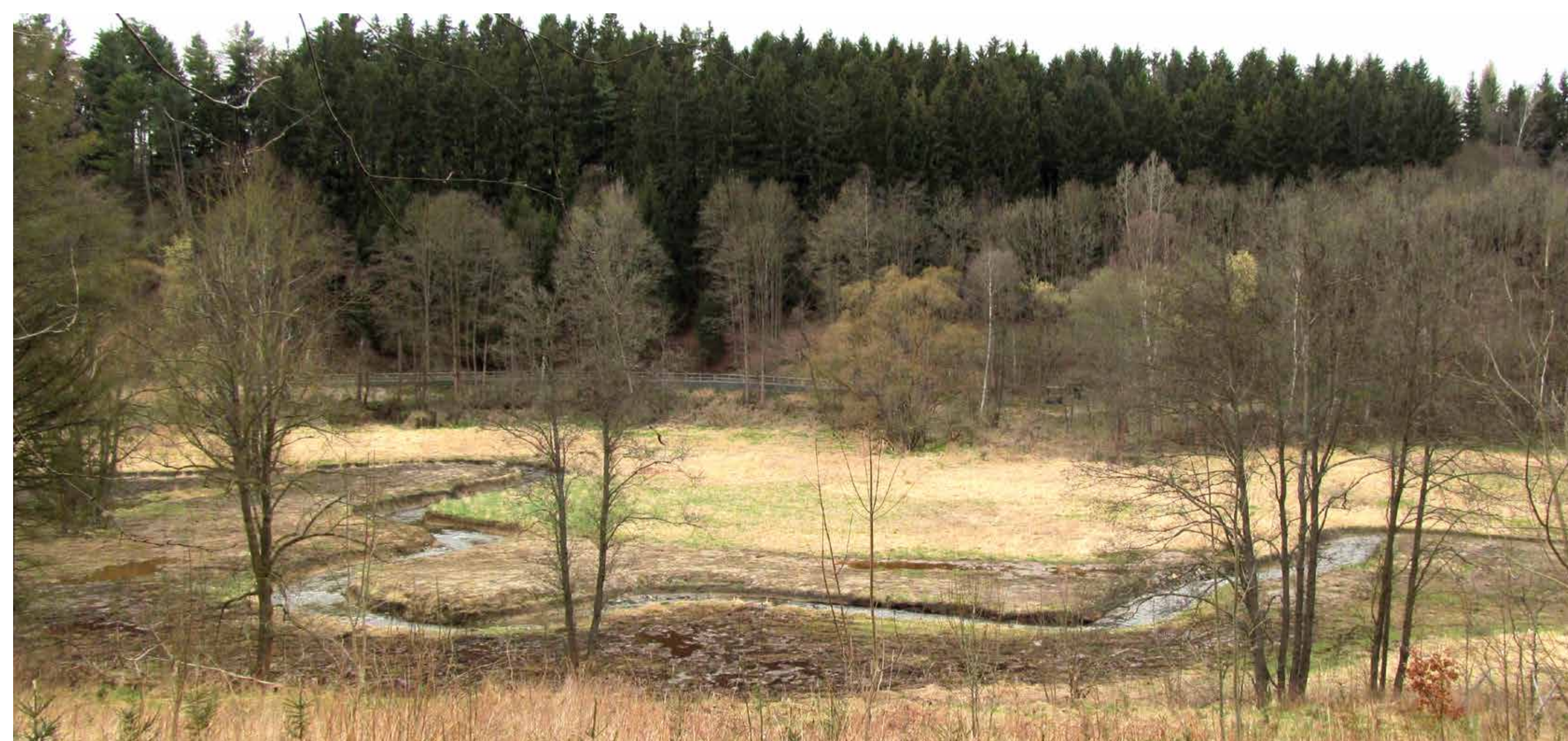
Pohled na novou trasu, navrženou podle principů revitalizace; trasa je zvlíněná, vedená v podmáčené nivě View of the new route designed in compliance with revitalization principles; the route winds through a marsh in the valley.
