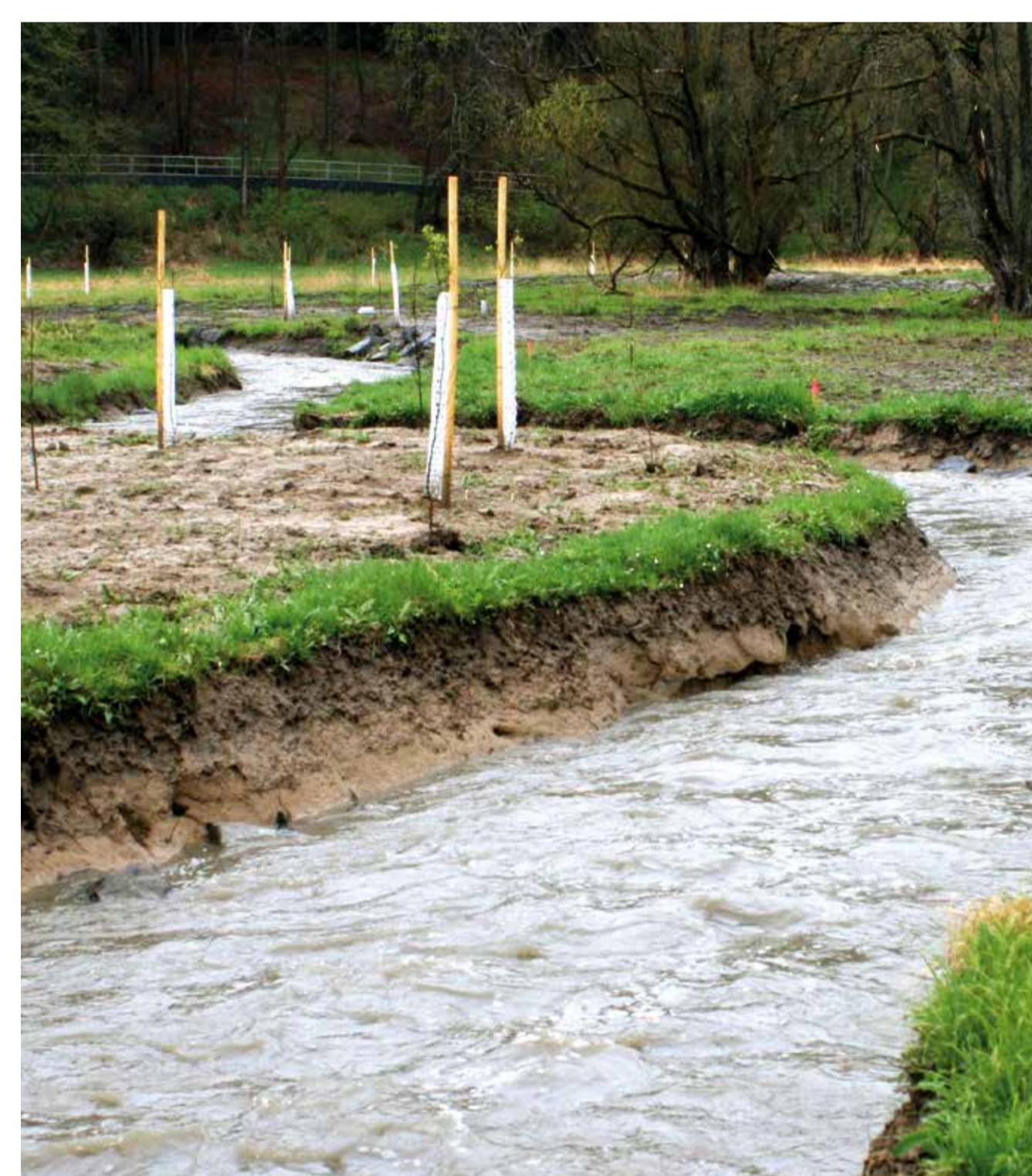
Nové koryto VT Halštrov s provedenou novou výsadbou doprovodné vegetace, dodatečně zpevnění břehů kořeny stromů A new basin of the Haltrov creek with new green plantation; creek banks additionally fixed with roots of trees.
