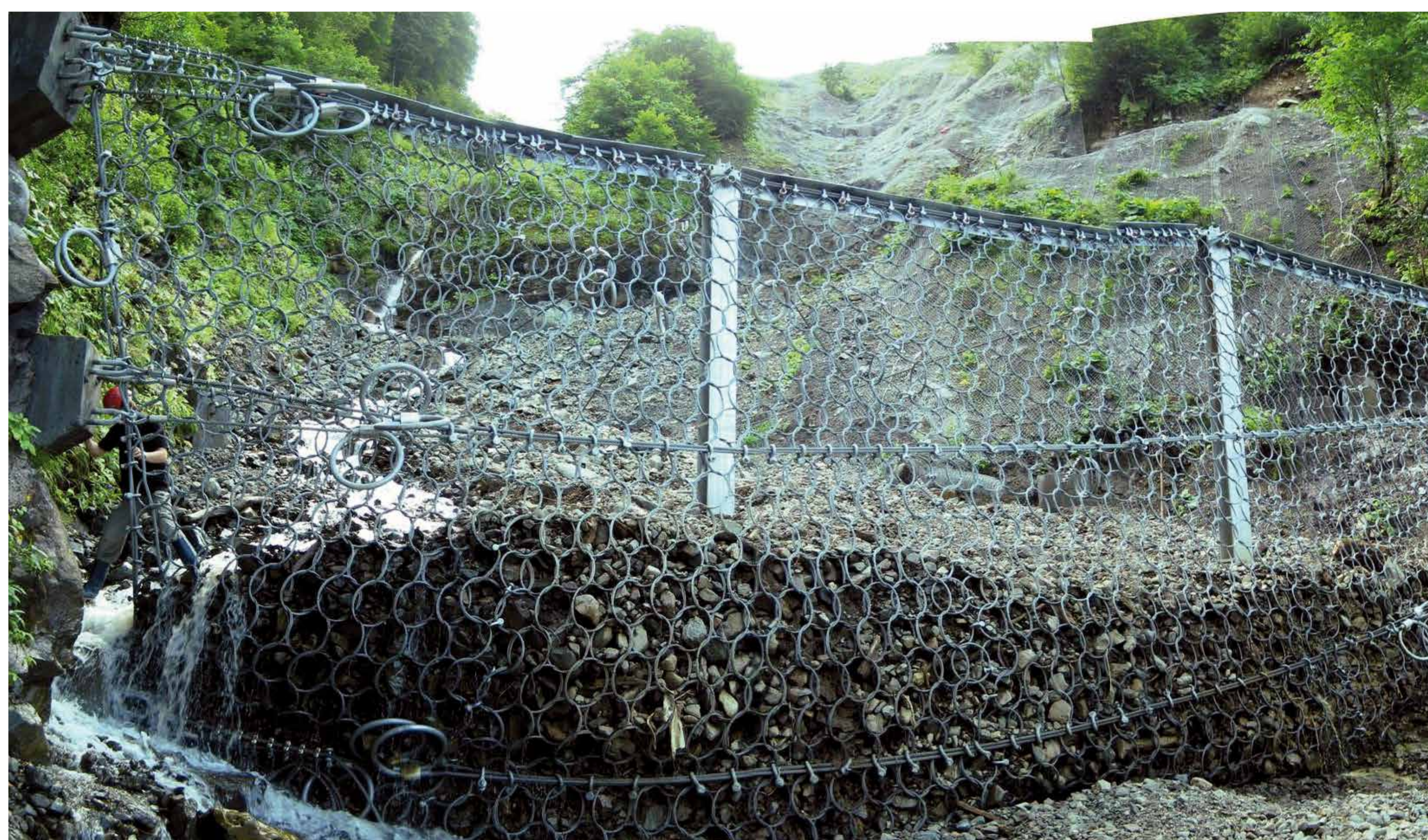
Ukázka funkce bariéry a jejího přetvoření při zachycení splavenin (dynamická bariéra UF 180 H6) Example of the barrier's function and its deformation when catching sediment runoff (dynamic barrier UF 180 H6).
