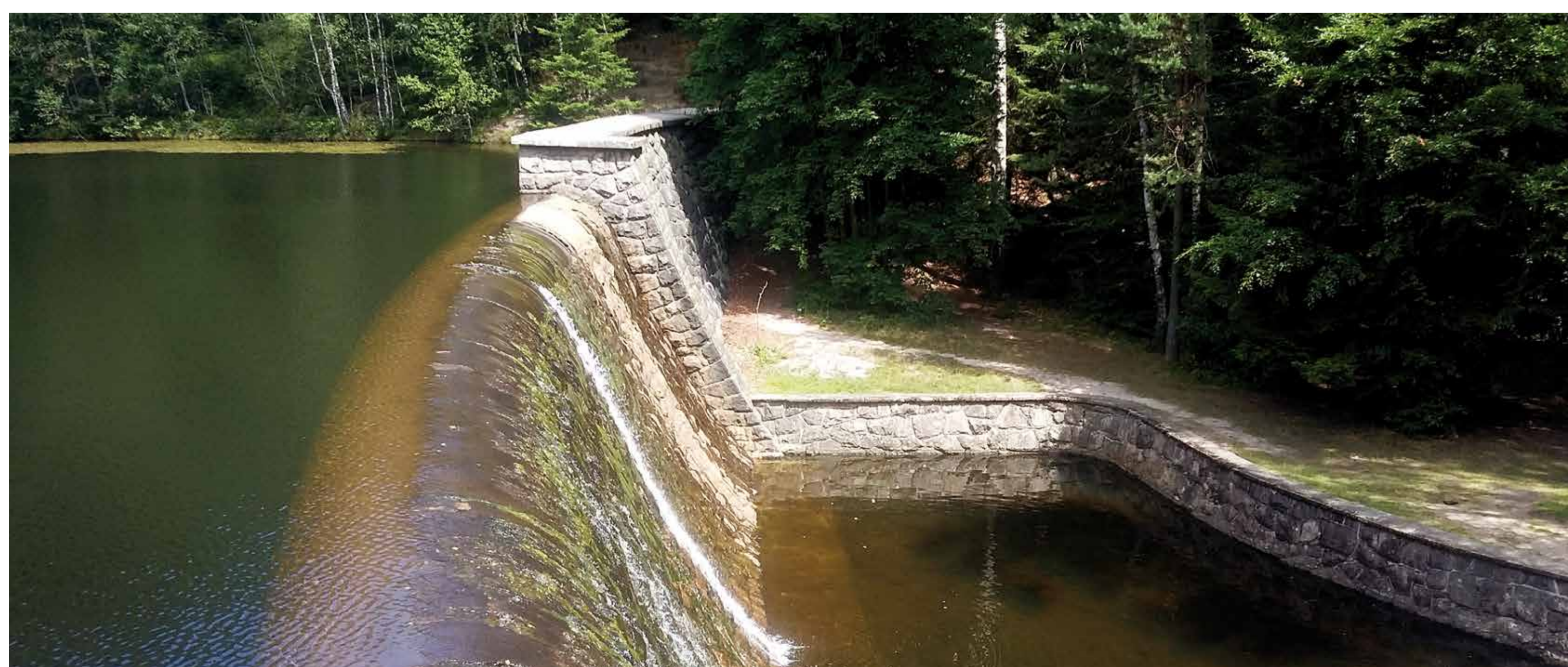
Původní přeliv tělesa hráze před rekonstrukcí The original dam's spillway before the renovation
