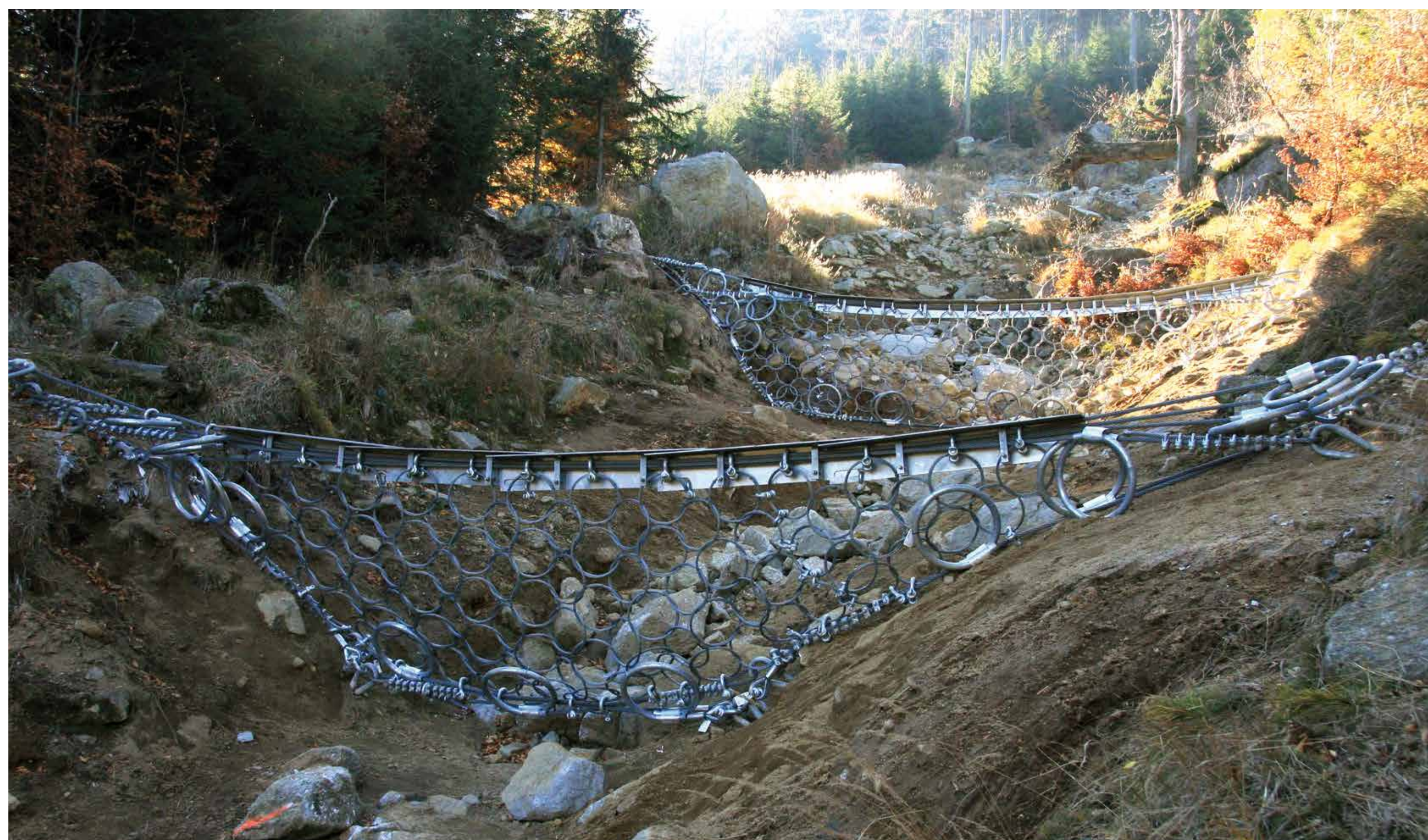
Vybudované flexibilní bariéry GEOBRUGG VX na svahu Smědávské hory v CHKO Jizerské hory (první instalace bariér v rámci ČR) Debris flow barriers GEOBRUGG VX built in slopes of the Smědávská hora (Mountain) in the Jizerské hory (Jizera Mountains) Protected Landscape Area (the first installation of such barriers in the Czech Republic).
