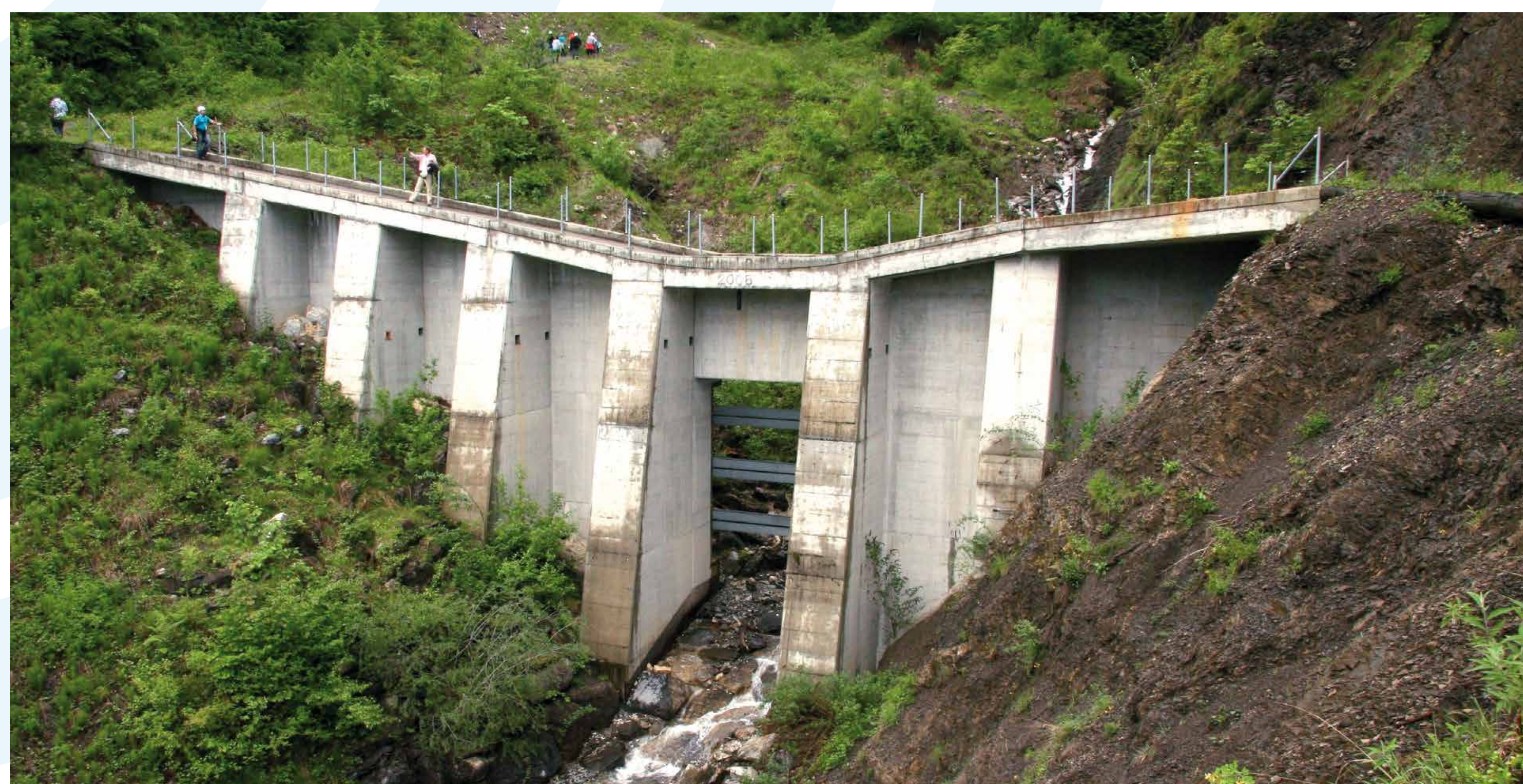
Statická bariéra v povodí Trachtbachu, tzv. otevřená přehrážka pro zachycení objemově velkých splavenin. Alternativou pro tyto objekty jsou flexibilní bariéry, které byly po roce 2005 v povodí rovněž postaveny Structural barrier in the river Trachtbach catchment area, the so-called open dam catches extensive volumes of sediment runoffs. Debris flow barriers are an alternative solution also built in this river catchment area after 2005.
